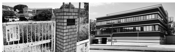
現在の第一幼稚園跡 福祉プラザしものせき
